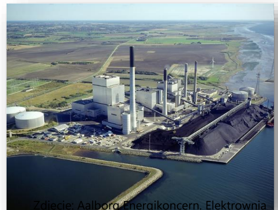
Zdjęcie: Aalborg Energikoncern. Elektrownia Nordjyllandsværket.
